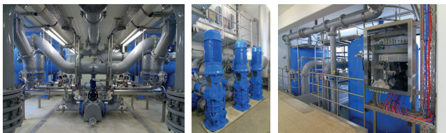
Grundsanierung Wasserwerk Großschwarzenlohe bei laufendem Betrieb
